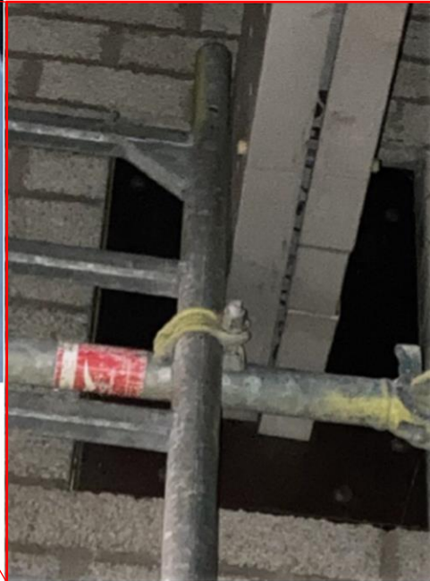
Trap van steiger nabij de geïsoleerde busbar van R8112. Hiernaast een close up.
